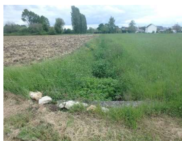
Coulée verte, exutoire des eaux pluviales du site de projet (vu vers le Sud depuis l'Avenue du Général de Gaulle)
