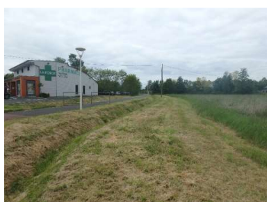
Fossé en limite Ouest du site d'étude au droit de l'Avenue du Général de Gaulle
