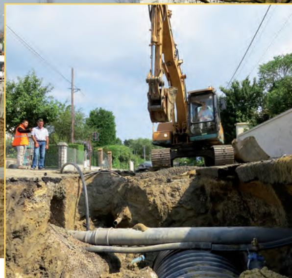
■ **Travaux d'assainissement eaux pluviales dans les rues de Chantelouze et du Chanoine Noël Carlotti** pour augmenter les diamètres de canalisation et ainsi endiguer les points de débordement.
