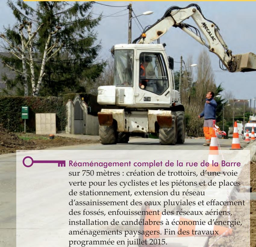
■ **Réaménagement complet de la rue de la Barre** sur 750 mètres : création de trottoirs, d'une voie verte pour les cyclistes et les piétons et de places de stationnement, extension du réseau d'assainissement des eaux pluviales et effacement des fossés, enfouissement des réseaux aériens, installation de candélabres à économie d'énergie, aménagements paysagers. Fin des travaux programmée en juillet 2015.
